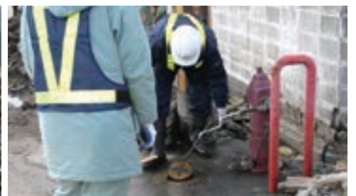
水道関係者による応急復旧活動
